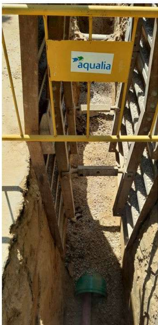
Zanja con entibación y relleno con grava
