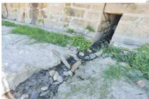
LA SALIDA DE UNO DE LOS DESAGÜES
